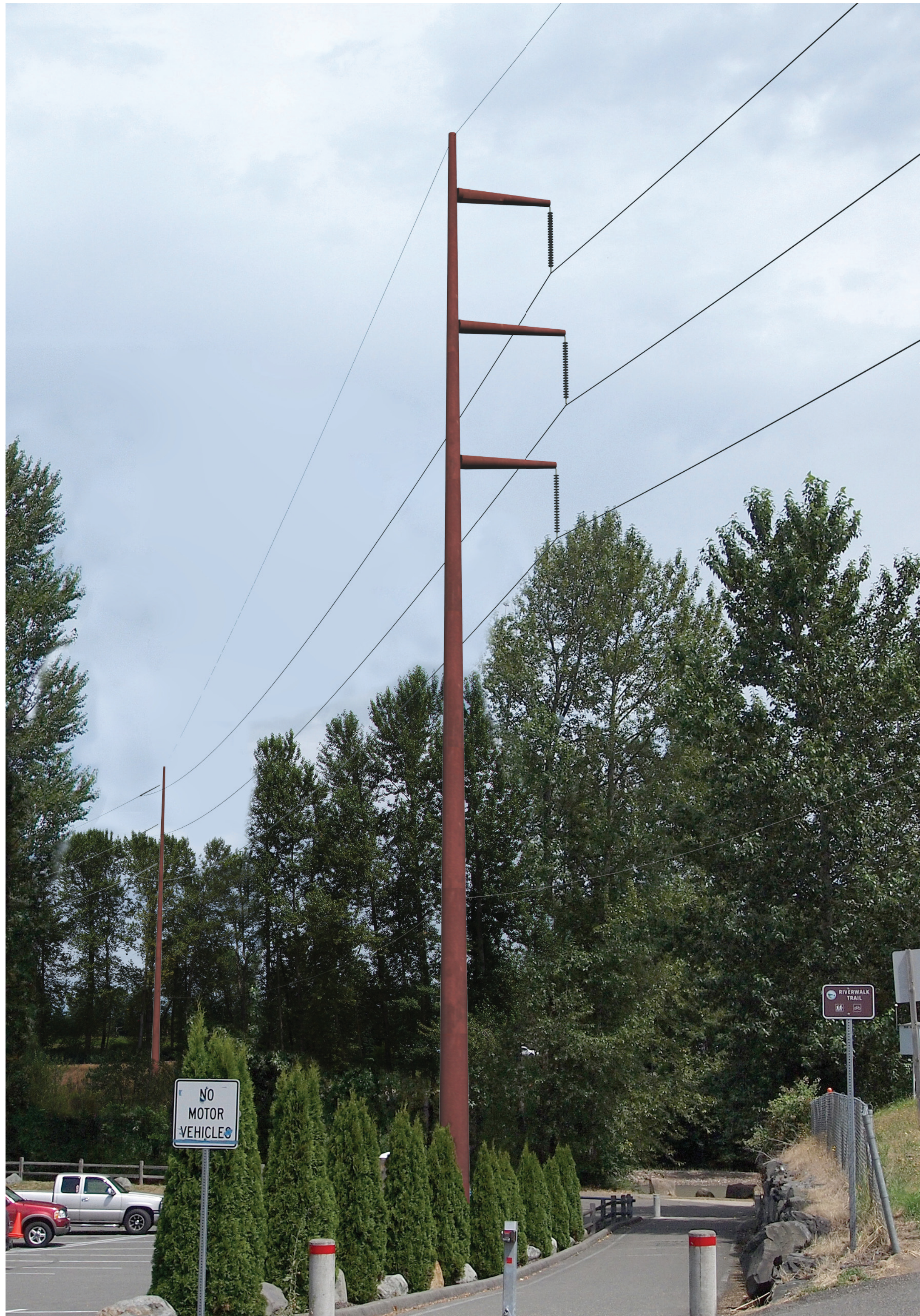
Single-circuit 230 kV steel pole
