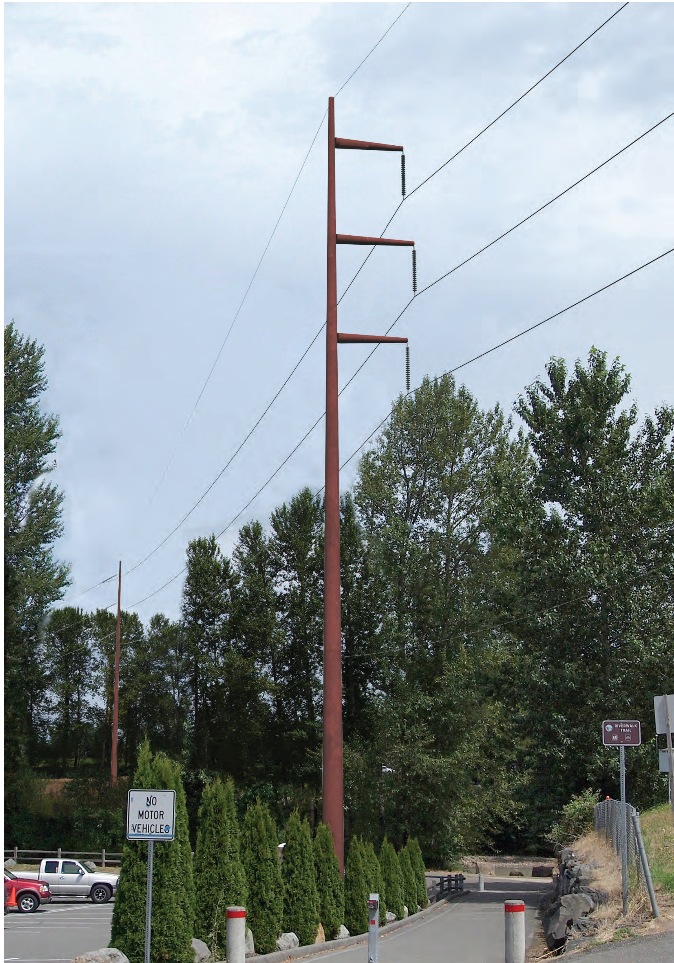
Single-circuit 230 kV steel pole
